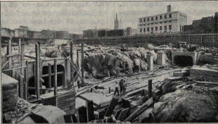
Aussachtungsarbeiten beim Bau des Bahnhofs der Pennsylvania Railroad.
