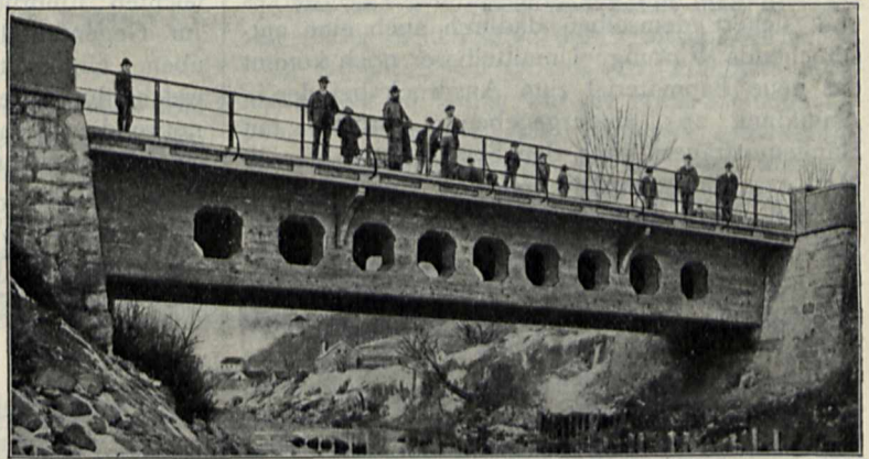
Strassenbrücke bei Krapina in Ungarn; Spannweite 20 m. Ausgeführt von G. A. Wayss & Co. in Wien.
