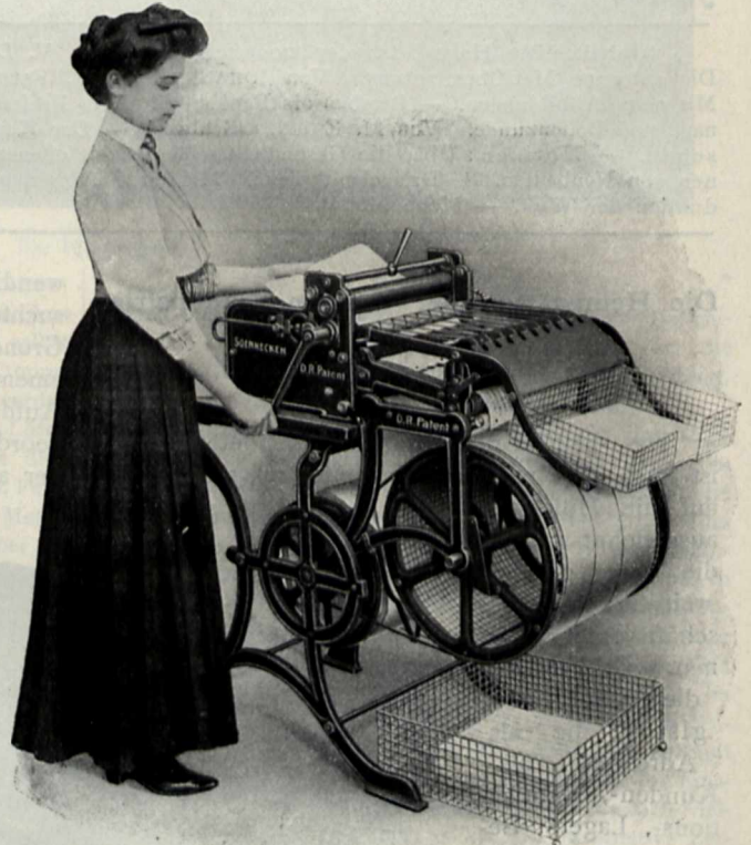
Soenneckens Schnell-Kopiermaschine Nr. 6K im Gebrauch.
