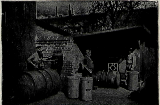
Abfüllen von Benzin in einen Vorratsbehälter.
