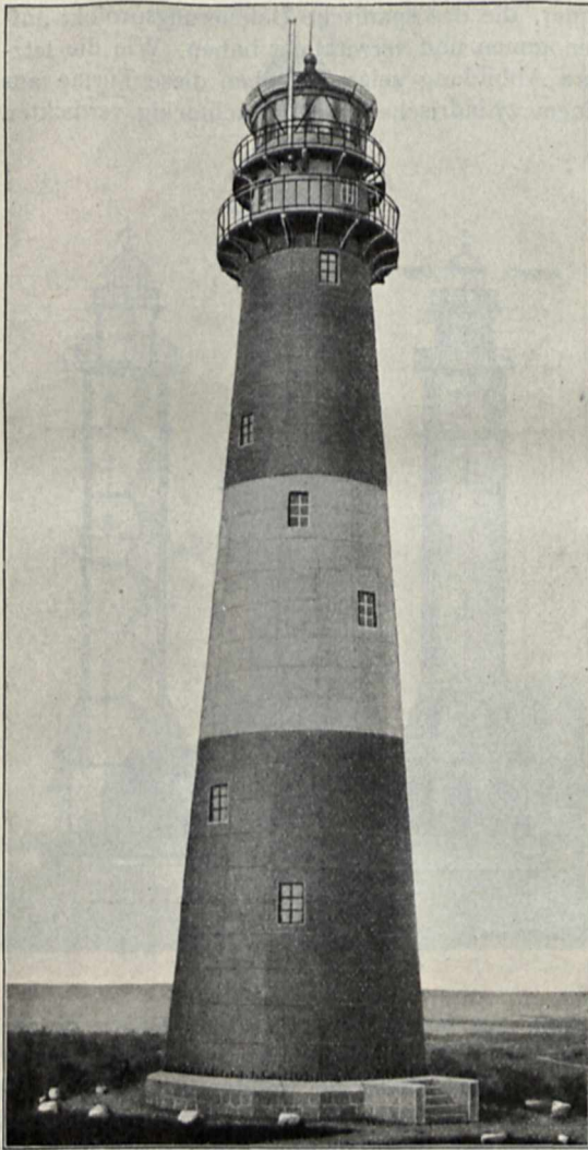
Gusseiserner Leuchtturm zu Stilow, Pommern.
