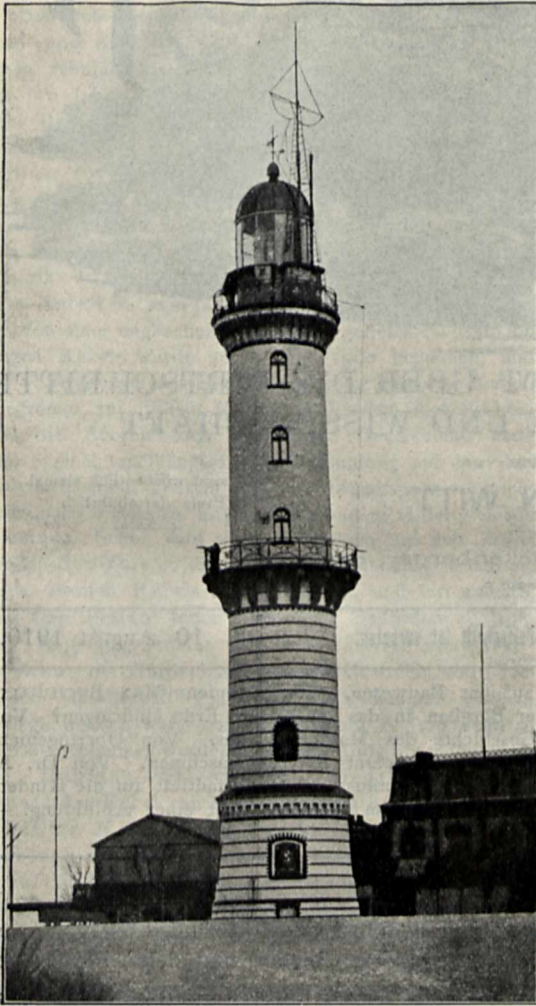
Leuchtturm zu Warnemünde.
