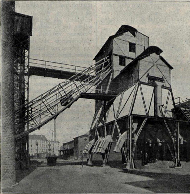
Selbsttätiger Schrägaufzug in der Gasanstalt Duisburg.
