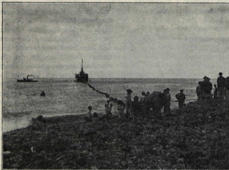
Verlegung des Kabels in Teneriffa, vom Ufer aus gesehen.
