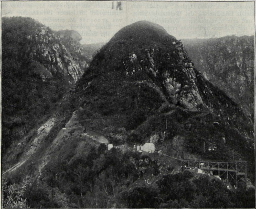
Drahtseilbahnanlage im Schumewald in Deutsch-Ostafrika (Steilabfall des Gebirgsrandes mit Winkelstation I).
