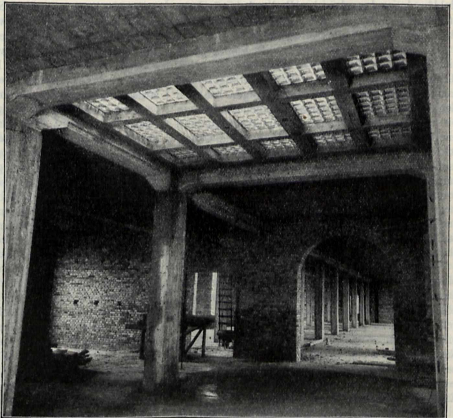
Untere Ansicht einer grösseren Glaseisenbeton-Decke.
