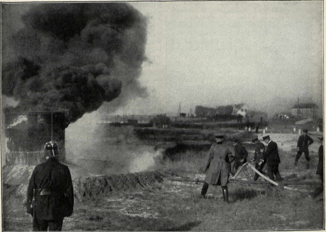
Kleiner Benzintank mit Umwallung nach Ablöschen des in die Umwallung geflossenen Benzins.
