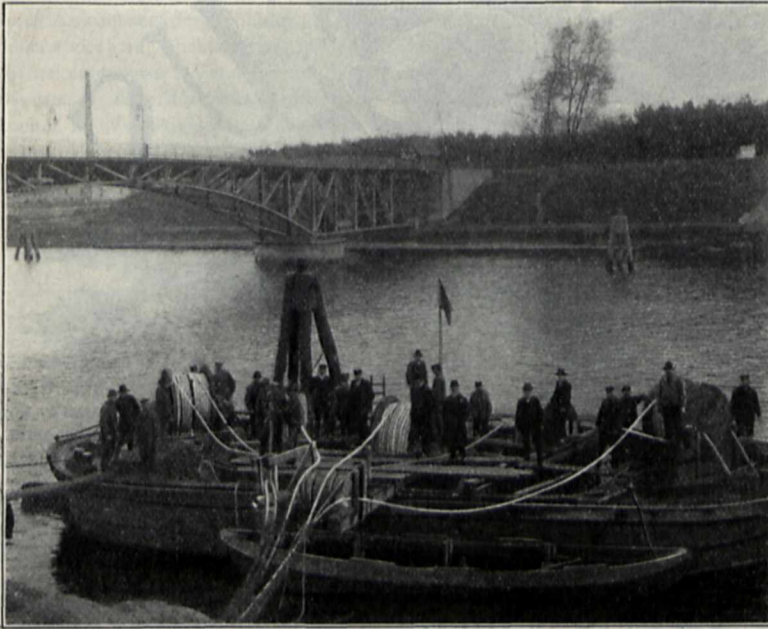
Anordnung der Trommeln sowie die Verankerung der Kabel im Kabelgraben am Ufer der Trave.
