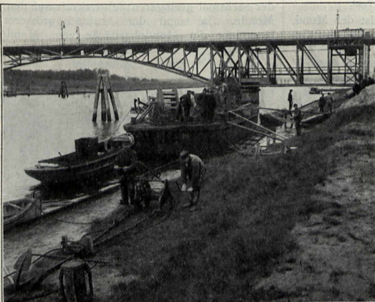
Kabelverlegung am Ufer.
