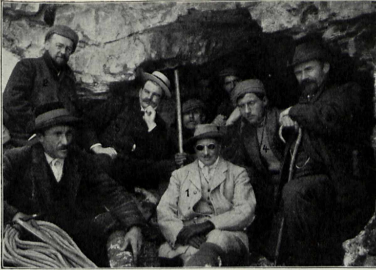
Nach Durchschlag des neuen Mönchstollens.
