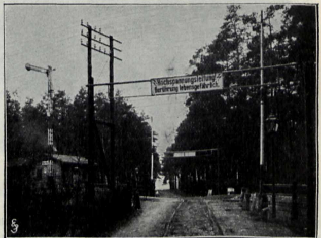
Schutzprofil mit Warnungstafel an Wegübergängen.
