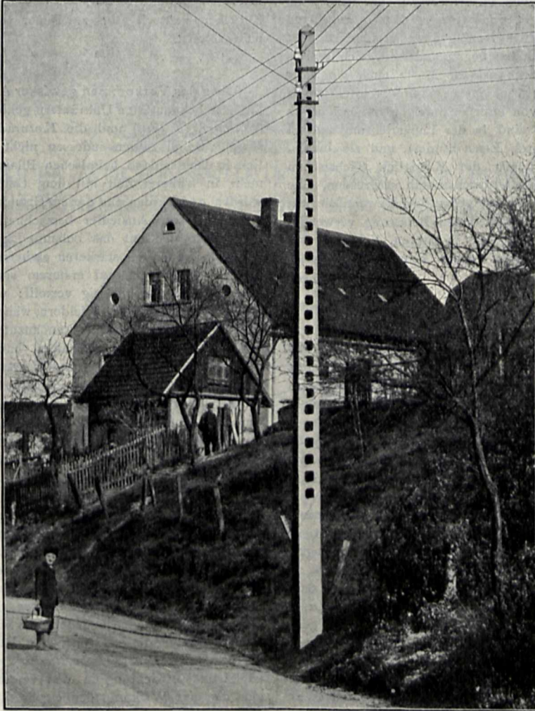
Eisenbetonmast der Firma Rud. Wolle in Leipzig.
