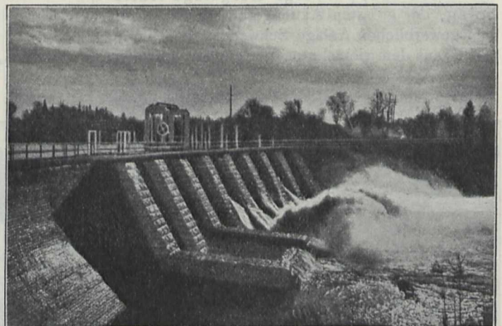
Wehranlage bei Bassalt.
