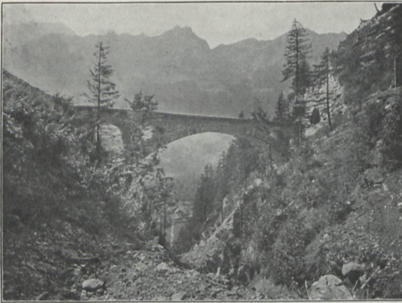
Brücke bei Mittholz.
