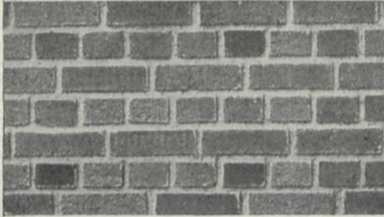
Betonung der Wagerechtwirkung beim Kreuzverband.
