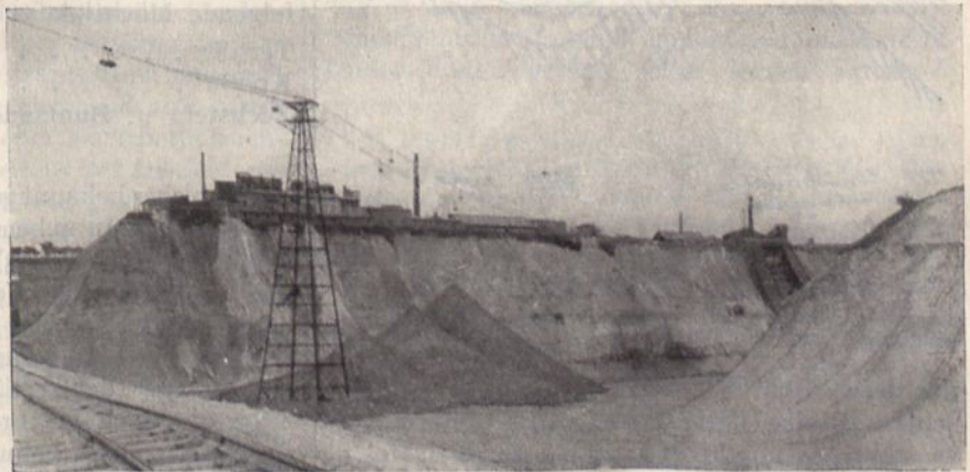
Die große Kreidegrube der Alsenschen Portlandzementfabrik in Lägerdorf bei Itzehoe.
