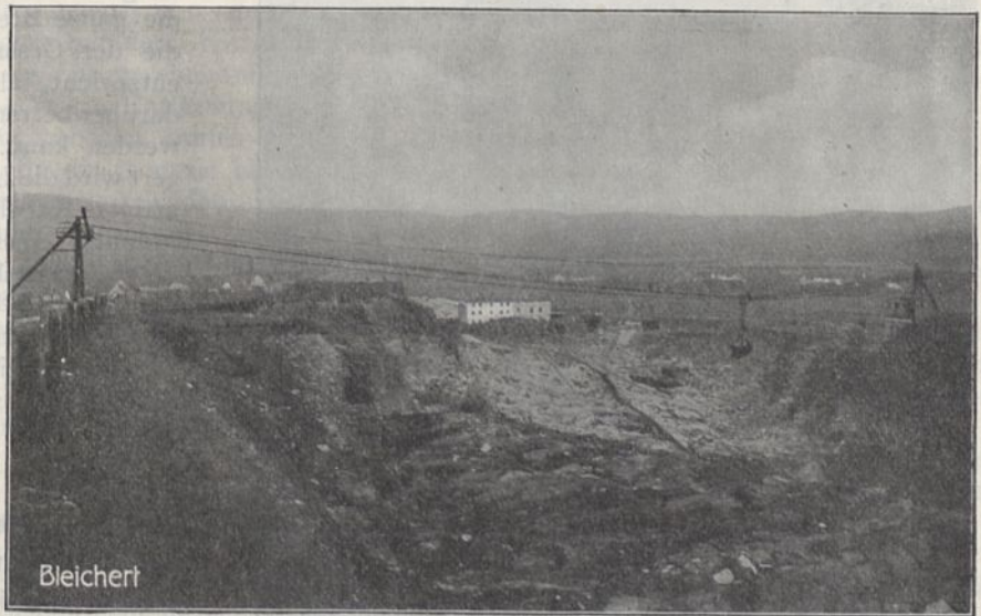
Feststehender Bleichertscher Steinbruch-Kabelkran von 165 Meter Spannweite und 4 Tonnen Tragkraft.
