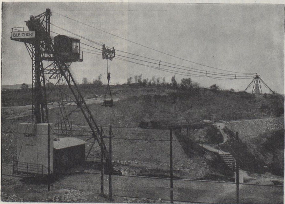
Radial verfahrbarer Steinbruchs-Kabelkran, Patent Bleichert, zum Transport von beladenen Muldenkippern von der Steinbruchssohle zum Grubenrande. Spannweite 220 Meter. Maximale Tragkraft 5000 kg.
