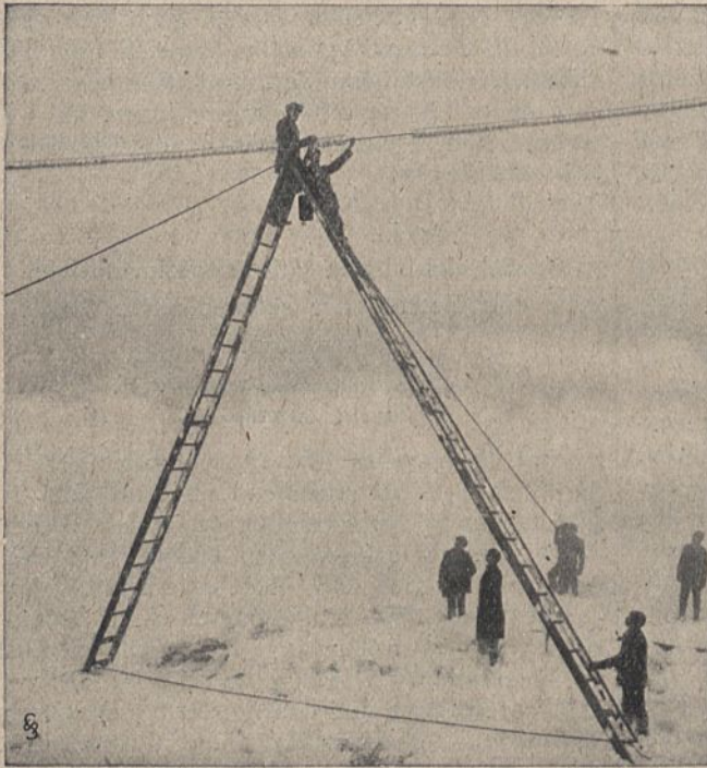
Vereiste Fahrleitung der Riksgränsbahn.
