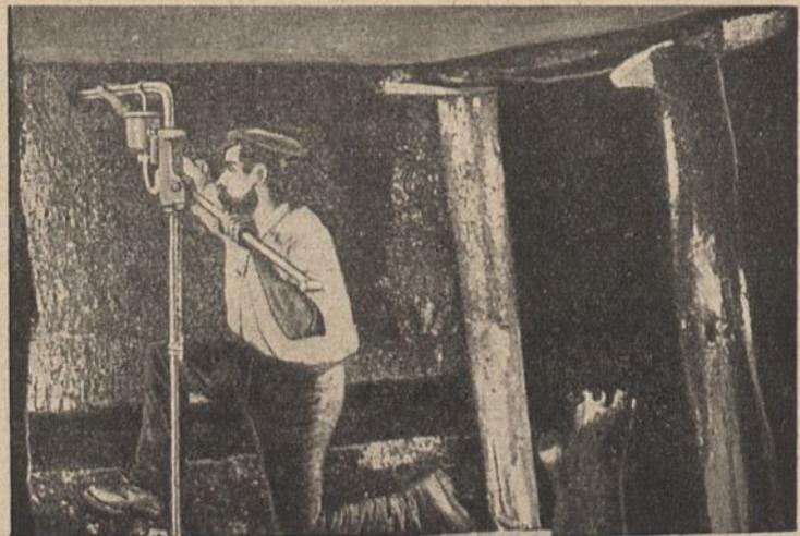
Druckwassersprengung im Bergwerksbetriebe.
