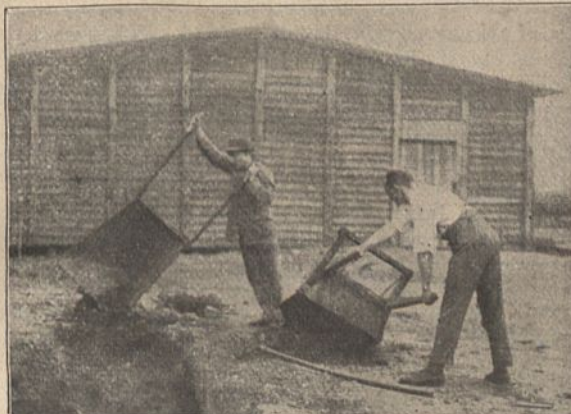
Entleeren der Schnelladeschiebkarre durch Drehung um 90^\circ , einer gewöhnlichen Schiebkarre um 180^\circ .
