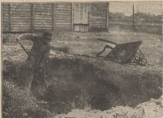
Beladen der umgelegten Schnelladeschiebkarre aus einer Grube heraus.
