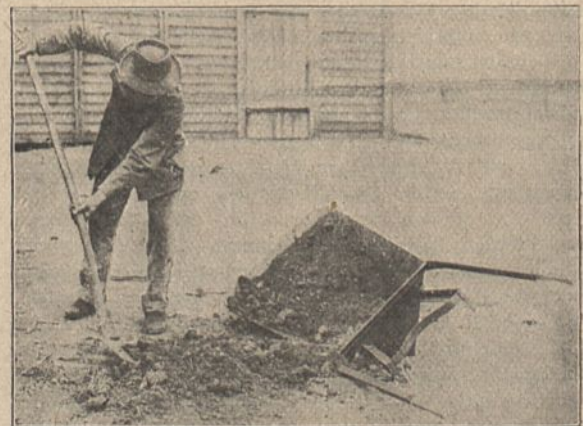
Beladen der umgelegten Schnelladeschiebkarre zu ebener Erde.
