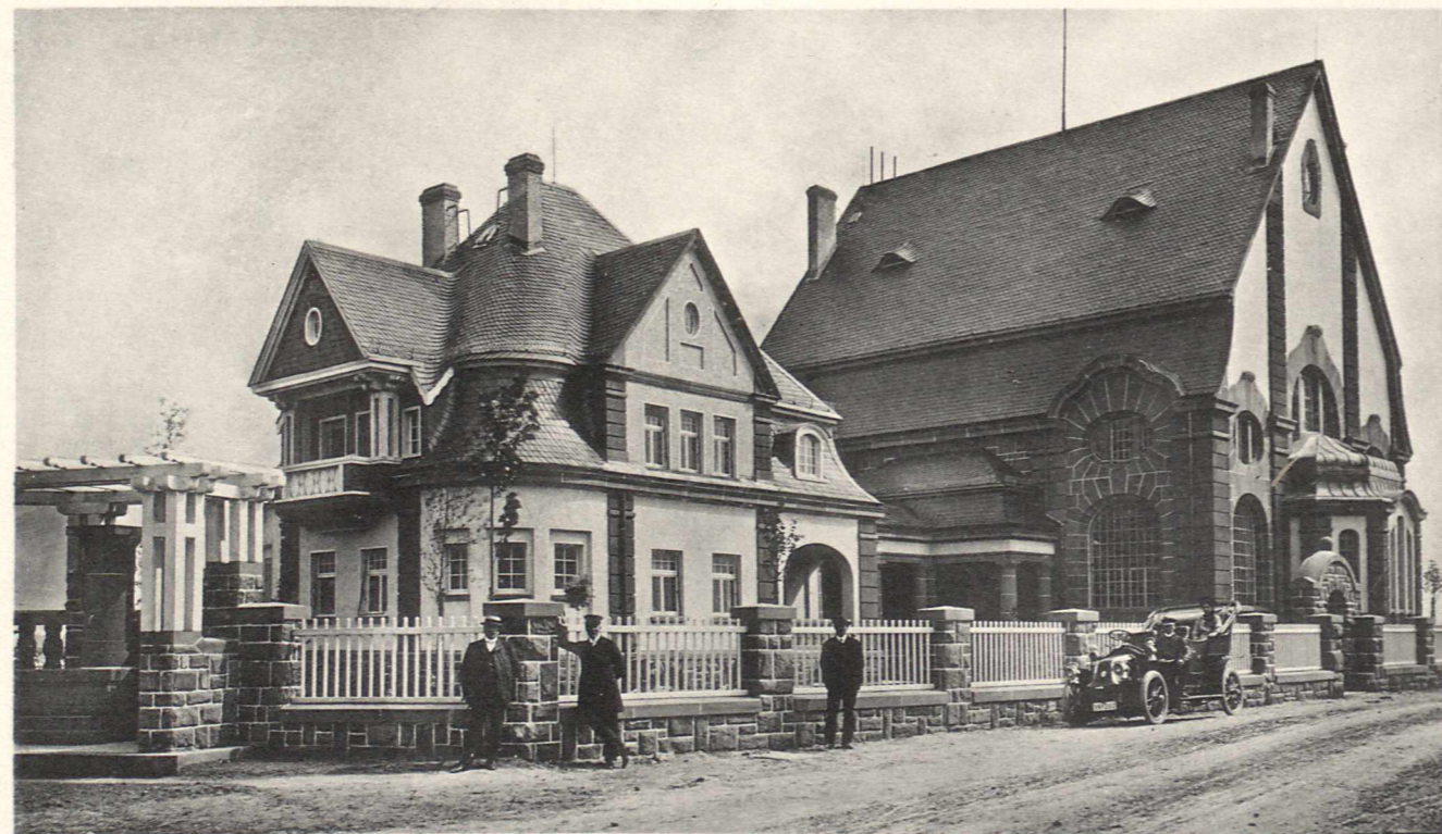
Abb. 3. Ansicht von der Straße nach Gimbsheim.
