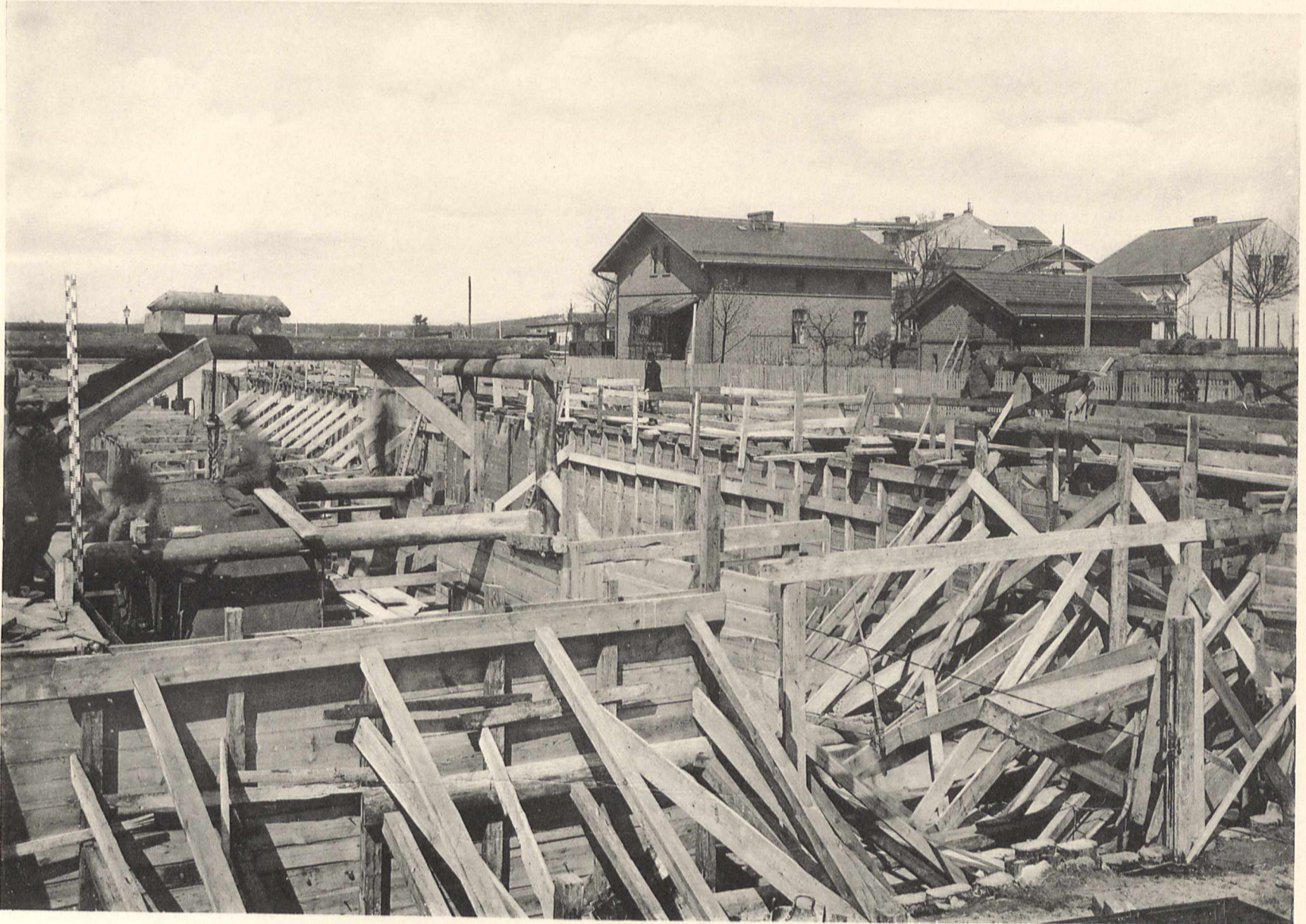
Abb. 1. Blick von Südost.
