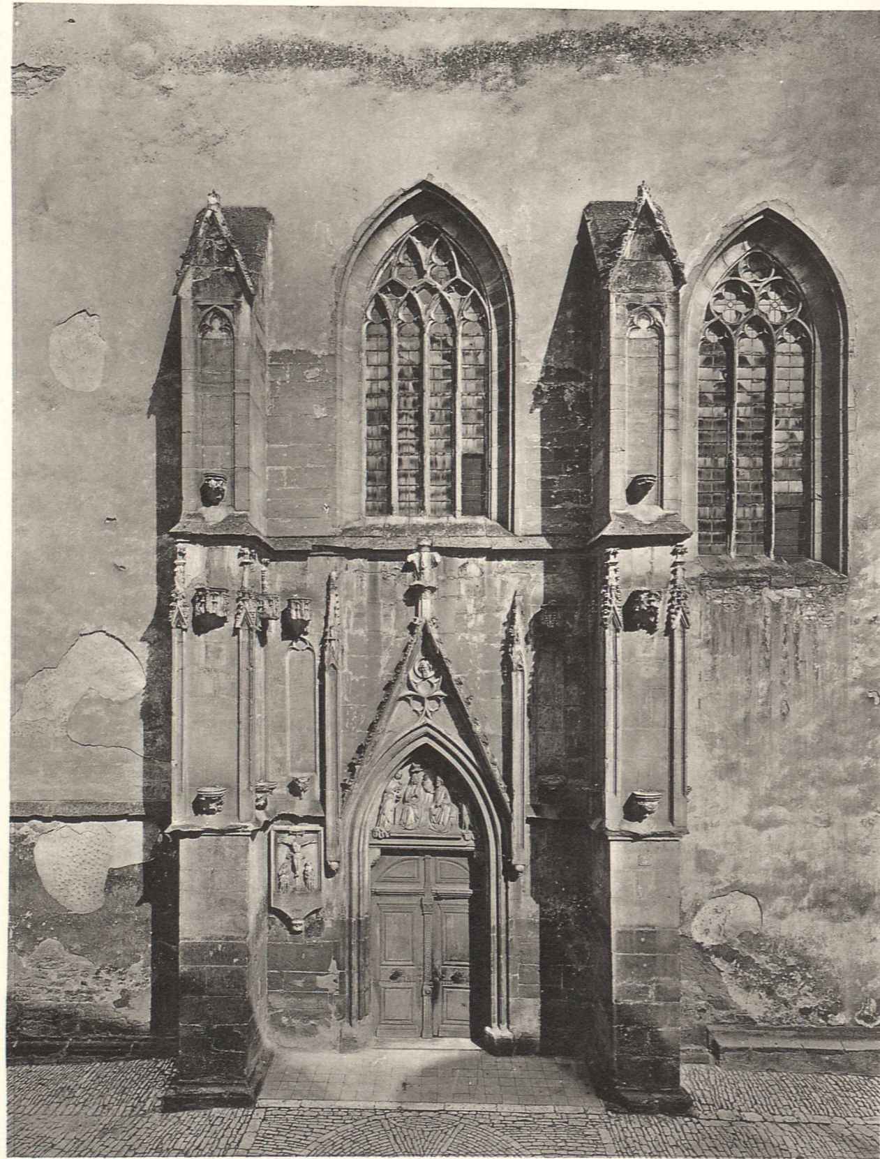
Abb. 1. Westportal vor der Wiederherstellung.
