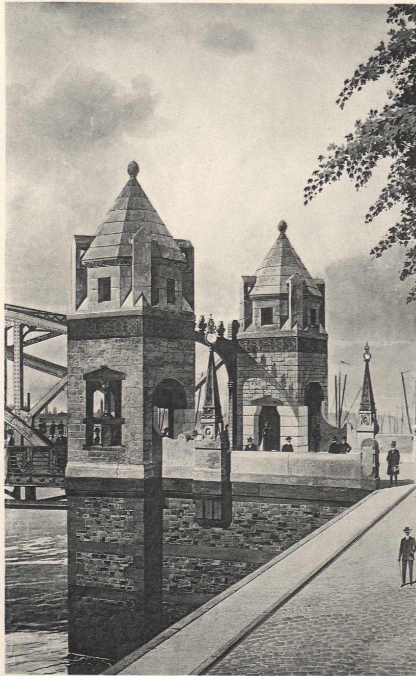
Abb. 1. Nordportal der Ruhrbrücke.
