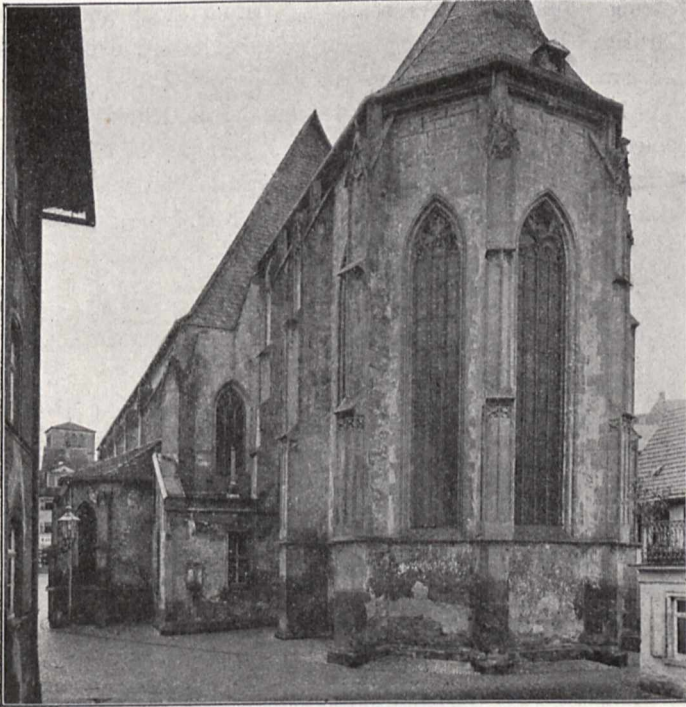
Abb. 1. Ostseite vor der Wiederherstellung.
