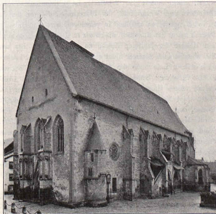
Abb. 2. Süd- und Westseite vor der Wiederherstellung.
