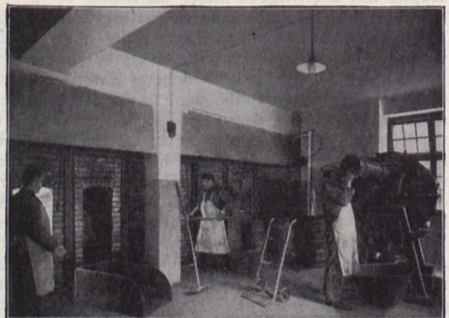
Brenn- und Mahlanlage, sogenannte Gekrätzmühle, für goldhaltige Rückstände.
