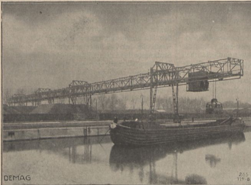
Verladebrücke von 140 m Länge mit Greiferlaufkatze, Straßburg im Elsaß.
