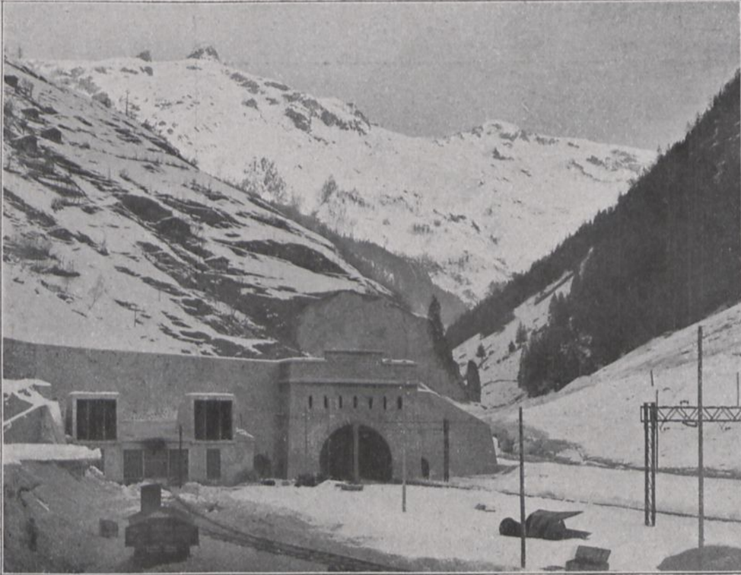
Lötschbergbahn, Tunnelportal in Goppenstein.
