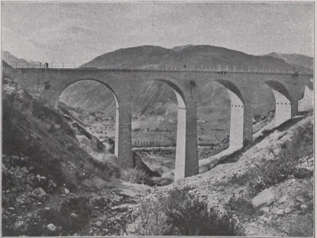
Viadukt bei Lalden im Rhönetai.
