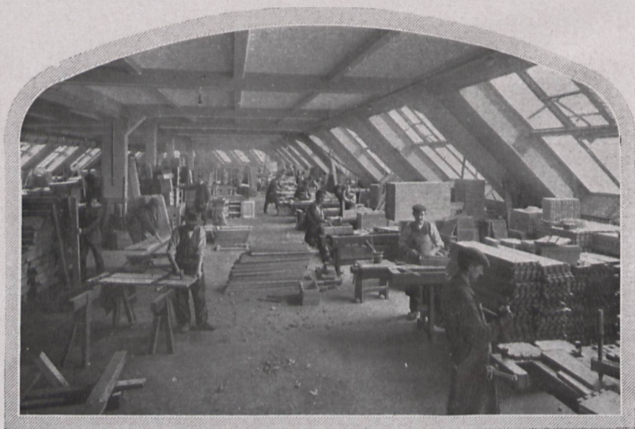
Tischlerei, Bauteil A, 5. Stockwerk.
