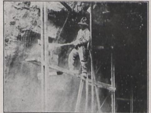
Bild 5. Abdichtung eines Tunnels.
