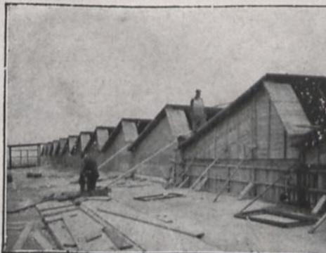
Bild 6. Torkretierung von Dächern und Wandflächen bei Fabrikgebäuden.
