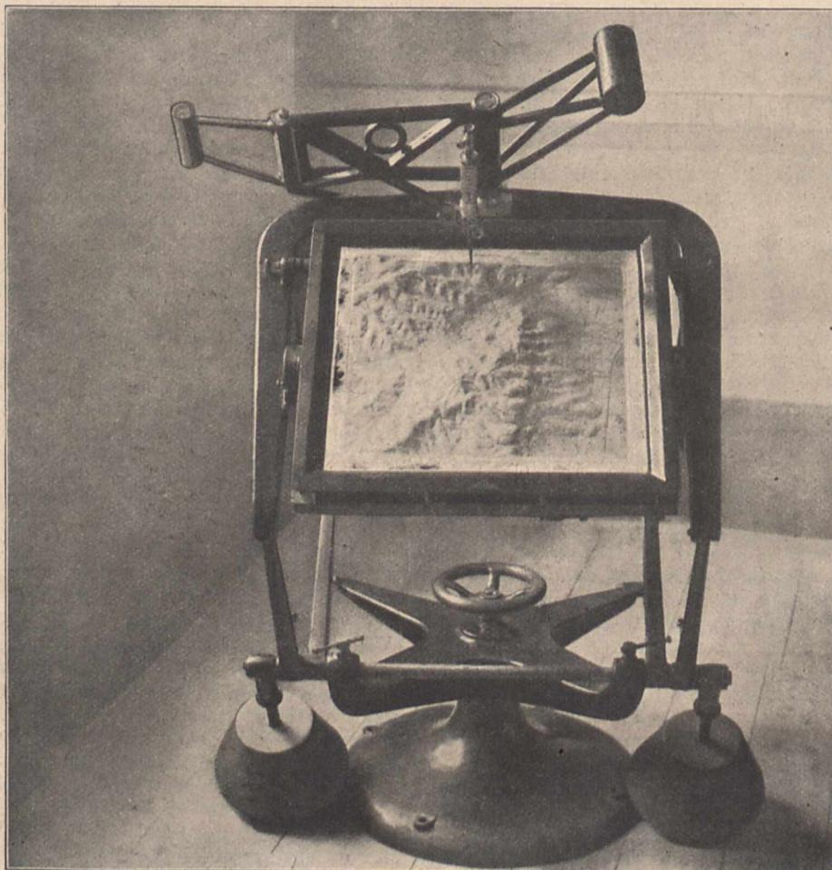
Fig. 1. *Fast fertiges Urmodell eines Kartenreliefs im Kontrollapparat.*
