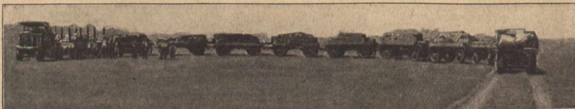
Fig. 2. Müllerzug mit 10 Anhängewagen für 60 t Nutzlast bei 250 PS Maschinenleistung.
