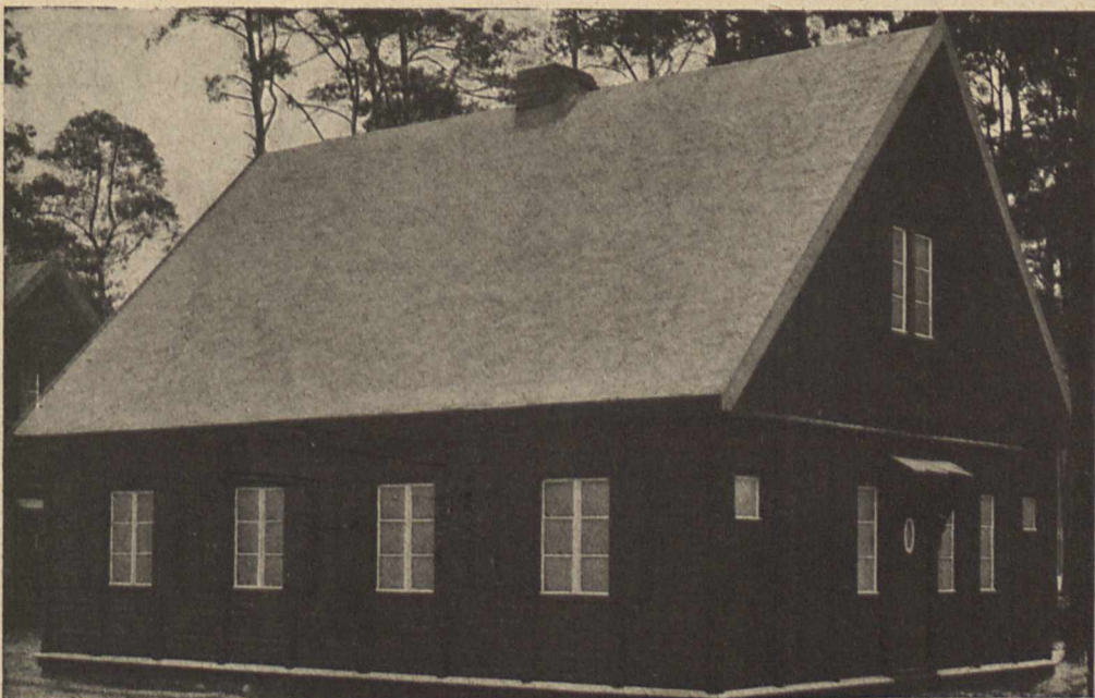
Fig. 2. Dasselbe Haus bezugsfertig nach 10 Tagen.
