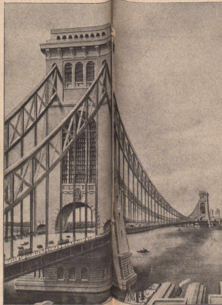
Fig. 2. Ansicht der Hudsonbrücke.
