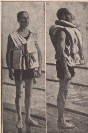
Links die bisher übliche Korkweste, rechts der neue Rettungsgürtel, eine mit Kapok gefüllte Weste mit kragenähnlichem Ring, welcher den Kopf über Wasser hält.
