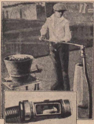
*Glühende Nieten werden in den Schlauch gebracht und mit Druckluft zur Verwendungsstelle befördert.*
