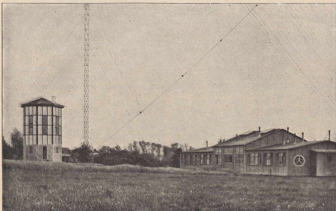
Fig. 5. Transradio-Anlage in Gelltown mit dem neuen Empfangsturm.
