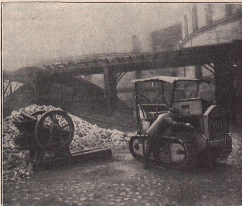
Fig. 4. Raupenschlepper treibt einen Schamottebrecher.
