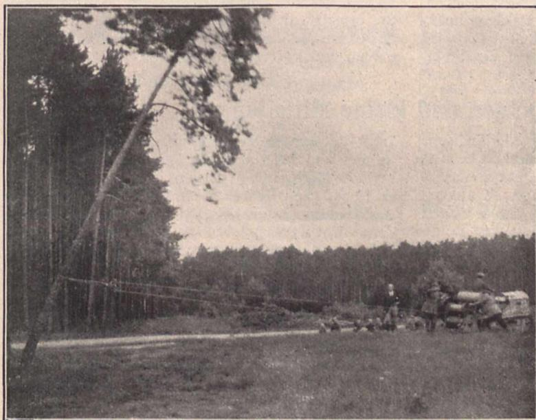
Fig. 3. Raupenschlepper mit Winde beim Baumroden.
