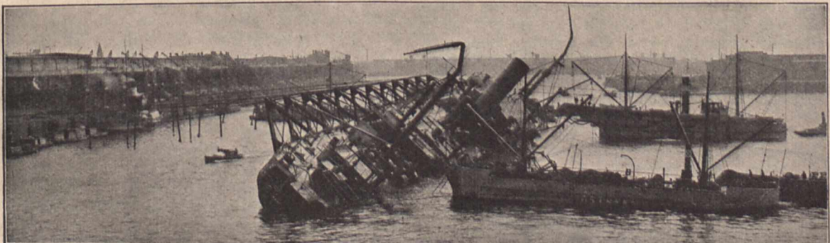
Fig. 2. Beginn der Aufrichtung.
