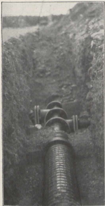
Fig. 2. Maschinengewickeltes Holzrohr
