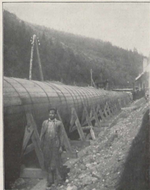
Fig. 3. Flanschenlose Holzrohrleitung
