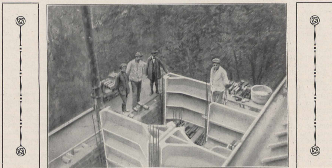
Fig. 4. Getreidesilo-Rank im Bau bei Schultze-Dellwig, Soelde (Westf.).
