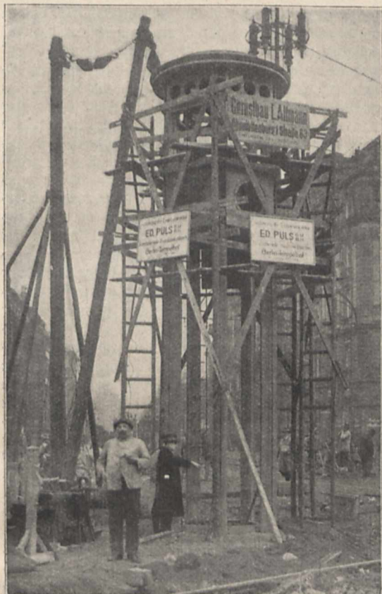
Fig. 1. Der Verkehrsturm im Bau.
