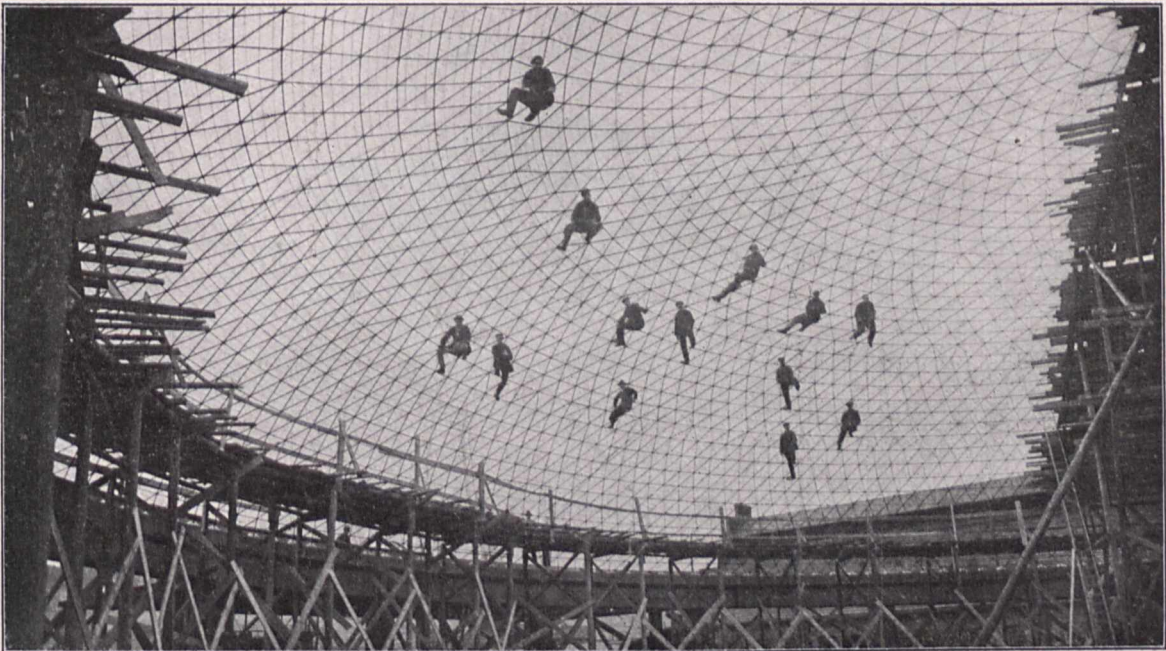
Fig. 2. Die Tragfähigkeit des dünnen Eisengerippes.
