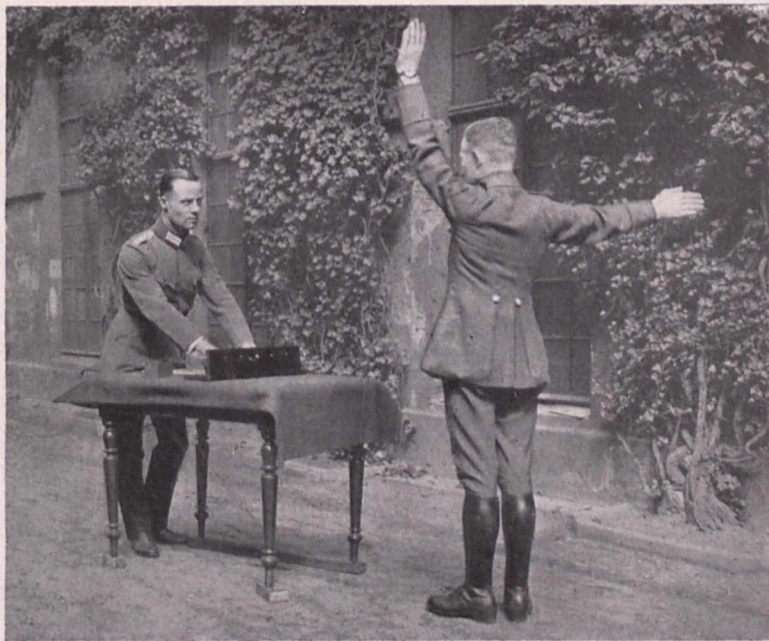
Fig. 5. Reizbrett (nach Dr. Schulte) zur Prüfung der Mehrfachhandlung bei den Winksignalen der Verkehrspolizei mit drei Reizen: rot — weiß — grün, wie bei den Verkehrstürmen.
