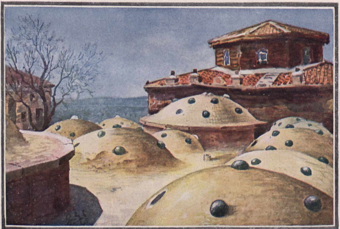
Fig. 9. Die Kuppeln eines großen Bades in Angora. Das Licht fällt durch die kleinen Glasaugen ein; nur die Eingangshalle (rechts) erhält ihr Licht durch die seitlichen Fenster in dem hölzernen Dachaufbau.
