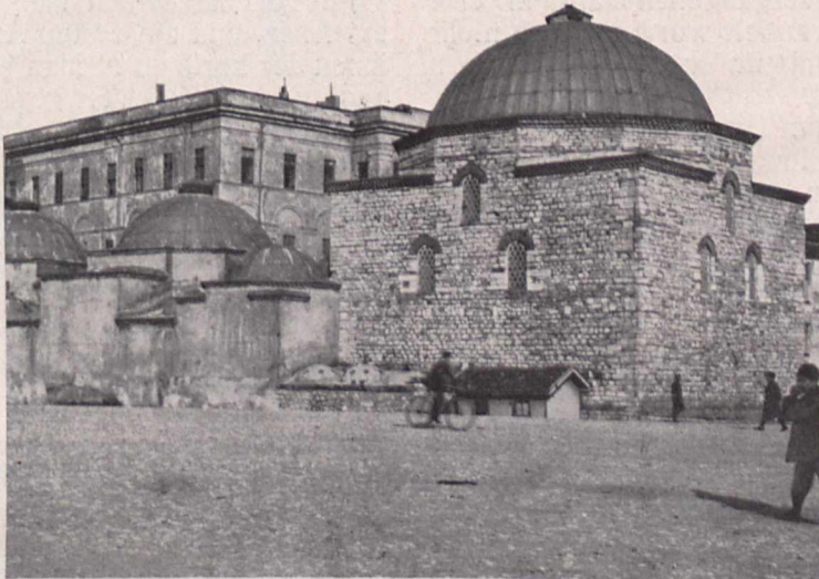
Fig. 7. Das Bad Hagia Sophia Hamam in Konstantinopel, erbaut 1553 von Sultan Suleiman dem Prächtigen durch Architekt Sinan. Charakteristisch ist die Größe der Eingangshalle und die gedrungene Gestalt der Schwitzräume. Es wird jetzt als Depot benutzt.
