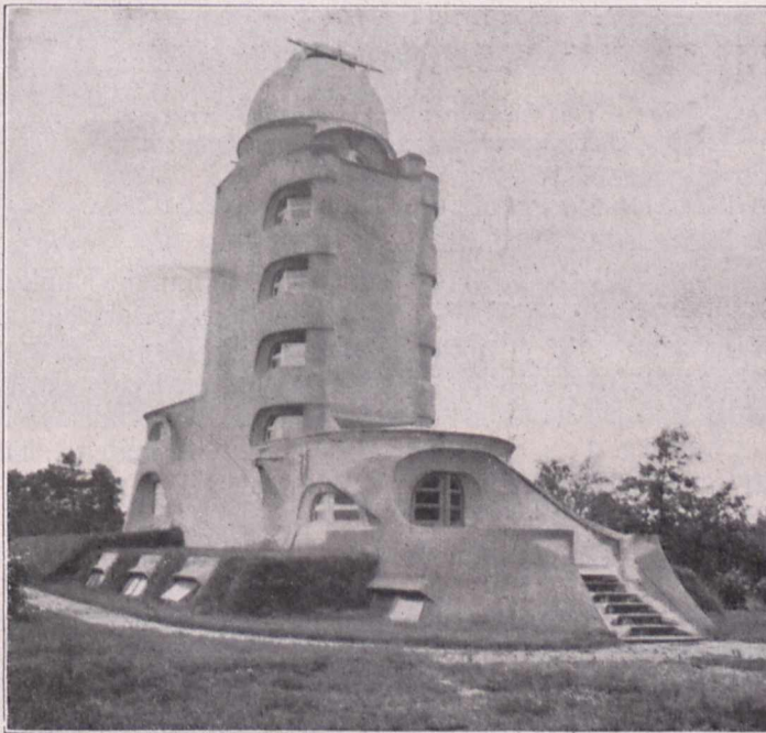
Fig. 2. Der Einsteinturm von Nordosten gesehen.
