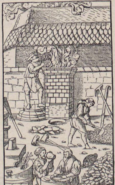
Fig. 3 (rechts). Stückofenbetrieb im 16. Jahrhundert.
