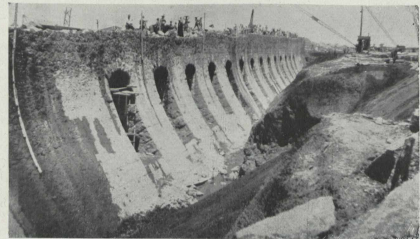
Fig. 3. Die Hauptdurchlässe des Damms: Das gebogene Mauerwerk der Unterstromseite.
