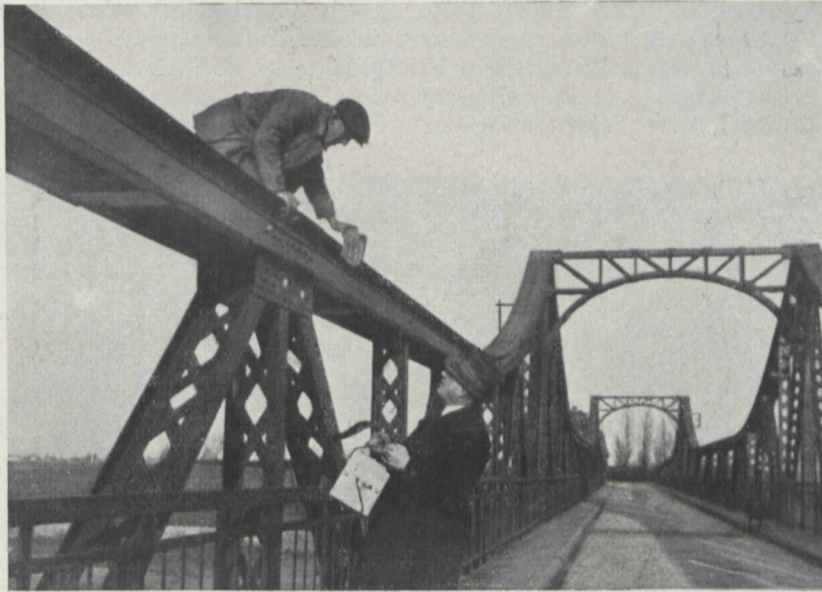
Fig. 3. Rostschutzprüfung an einer großen Brücke.
