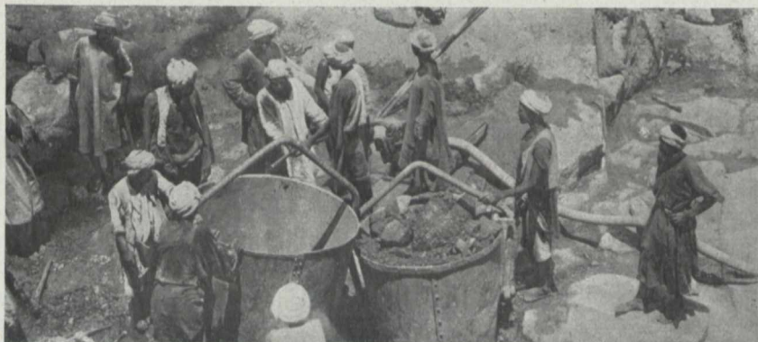
Fig. 5. Der teilweise aus nachgiebigem Erdreich bestehende Untergrund des Staudamms wird durch Aufschütten von Steinen verfestigt.
