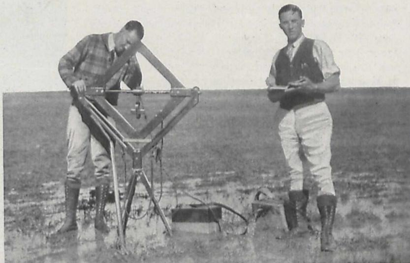
Fig. 3. Feldarbeit mit dem Induktionsrahmen. Schürfung auf Erdöl mittels der elektrischen Wechselstrommethode.
