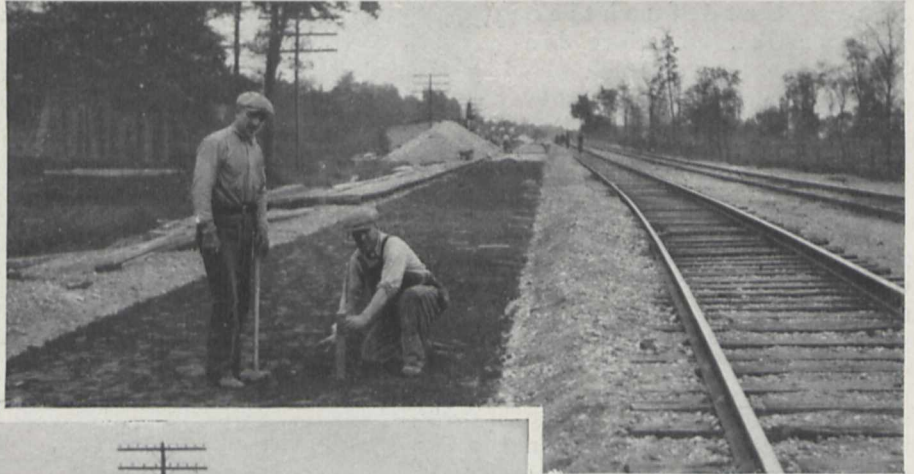
Fig. 1. Zur Stütze der schmalen Stahlträger für die Längsverfestigung werden kleine Pfähle durch eine dünne Sandschicht getrieben, die auf einer Zementmörtelschicht über dem alten Schienenunterbau aufliegt.
