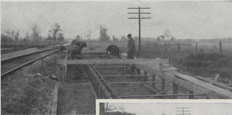
Fig. 1. Zur Stütze der schmalen Stahlträger für die Längsverfestigung werden kleine Pfähle durch eine dünne Sandschicht getrieben, die auf einer Zementmörtelschicht über dem alten Schienenunterbau aufliegt.
