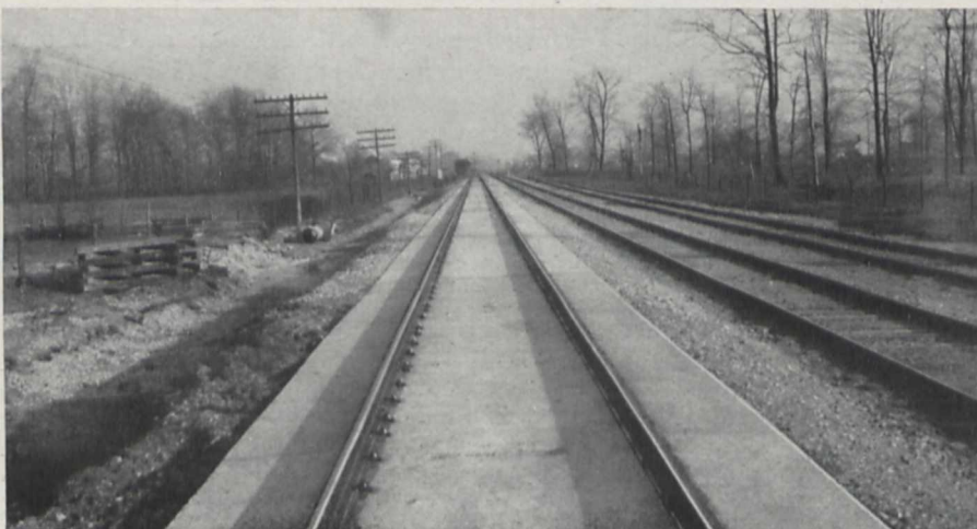
Fig. 3. Teilweise fertig mit Beton ausgegossene Strecke.
