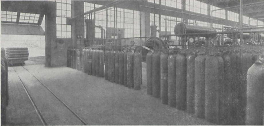
Fig. 3. Stahlzylinder, die zur Füllung an die Heliumgasleitung angeschlossen sind.
