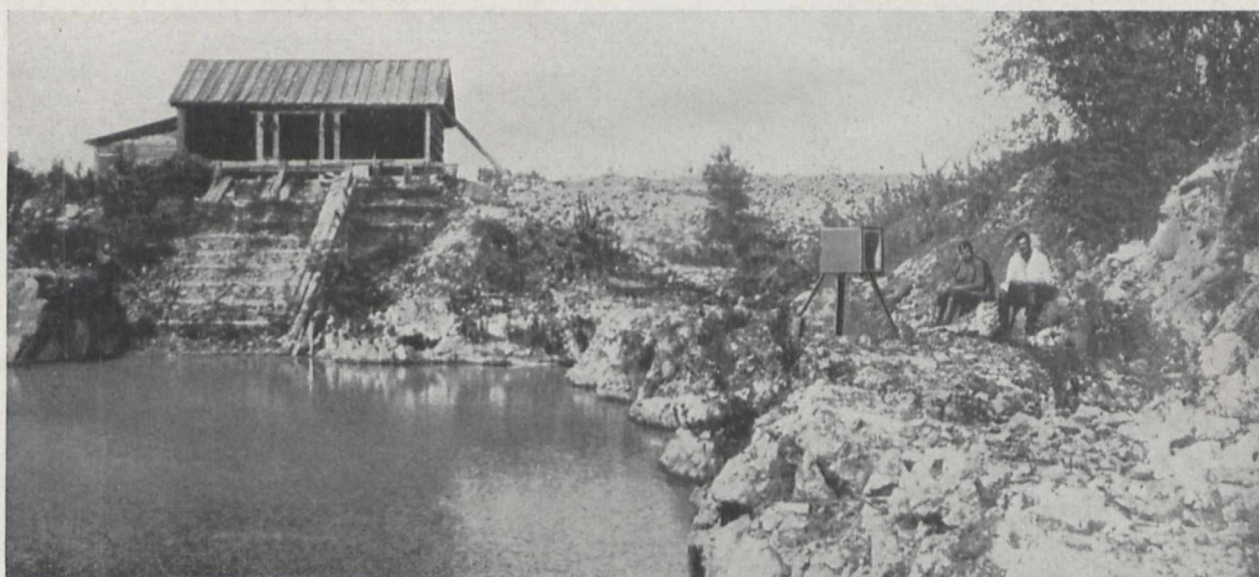
Fig. 2. Radiometer auf einer der Olenji- (Kirsch-) Inseln am Onega-See zur Prüfung des Radiumgehalts der Baryt- und Kalklager.
