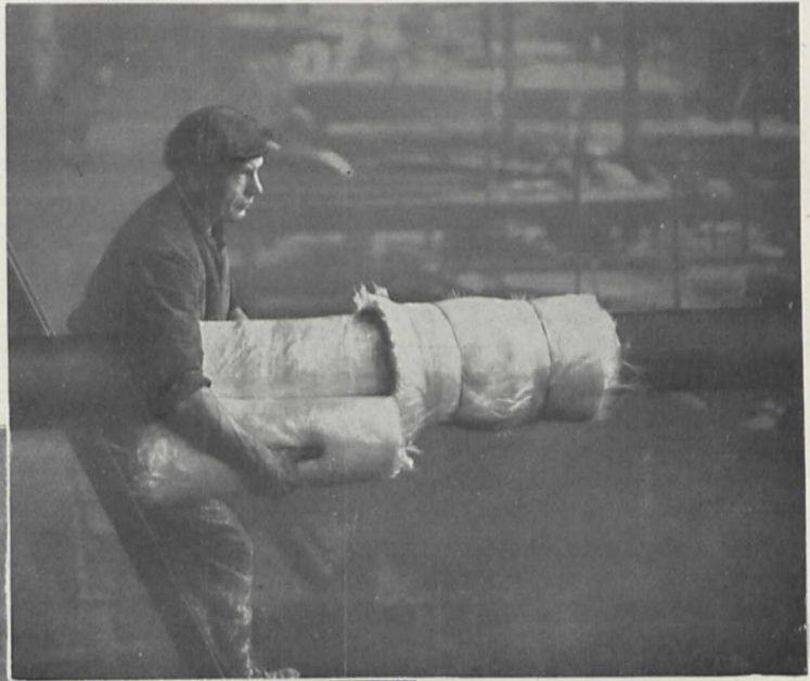
Fig. 1 (oben) u. 2 (nebenstehend). Ein Rohr wird mit Glaswolle wie mit einem Verband umwickelt.
